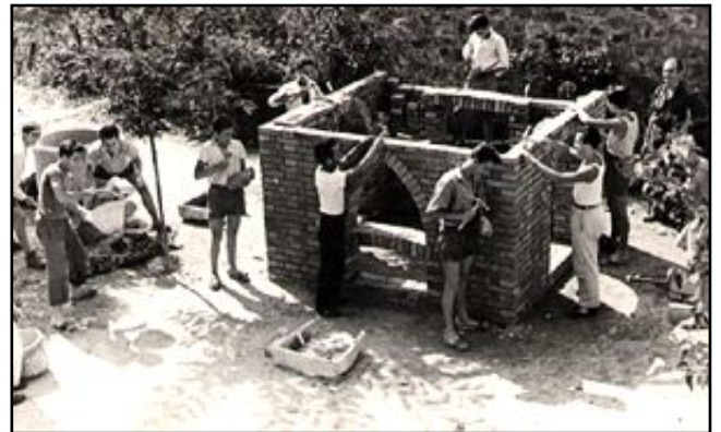
Inizio anni '50 del '900, corso di specializzazione per lavoratori edili
